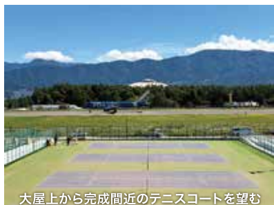
大屋上から完成間近のテニスコートを望む
