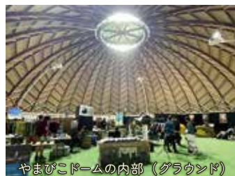
やまびこドームの内部（グラウンド）
