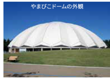
やまびこドームの外観
