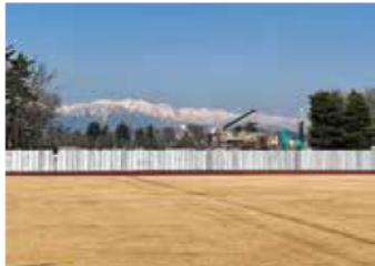
▲建て替え工事の進む陸上競技場越しに冠雪の北アルプスを望む
