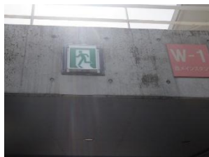
作業完了(試験点灯良好)
