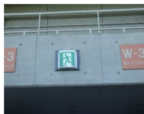
作業完了(試験点灯良好)
