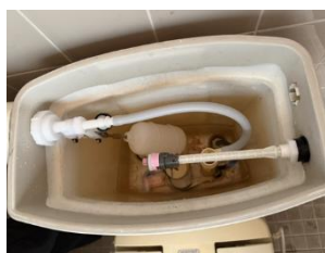
作業完了(不具合解消確認)
