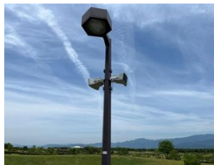
作業完了(不具合解消確認)
