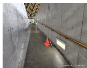
作業完了(試験点灯良好)
