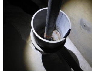
作業完了(不具合解消確認)
