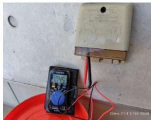
作業完了(正常動作確認)
