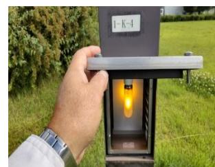
作業完了(試験点灯)
