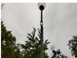
作業完了(試験点灯)
