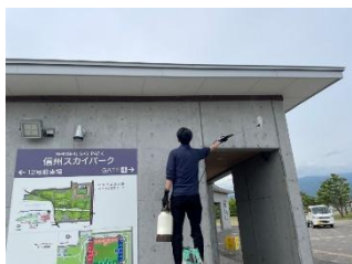
作業中 (23 号トイレ)
