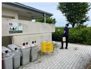
作業中 (17 号トイレ)
