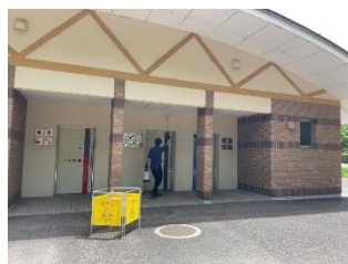
作業中 (25 号トイレ)
