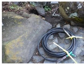
作業中(ホース抜き取り)
