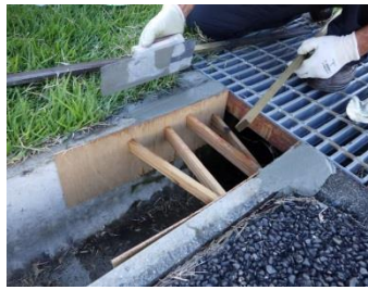
側溝の補修状況
