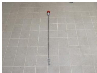
水抜き弁 シャフト引抜き
