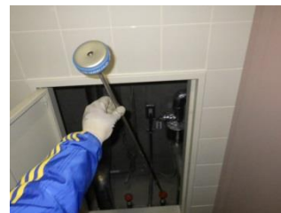
通水し聴音棒で点検
