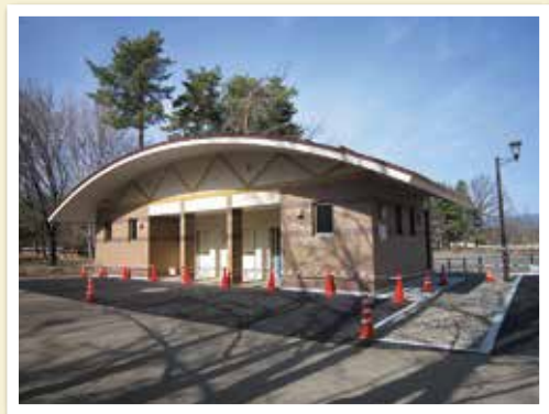
25号トイレ @ターミナルゾーン
