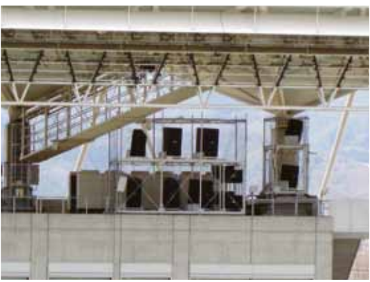
音響設備更新 【アルウィン】
