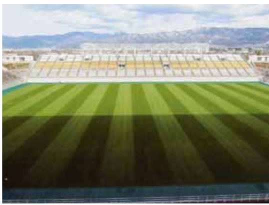
芝生張替工事 【アルウィン】
