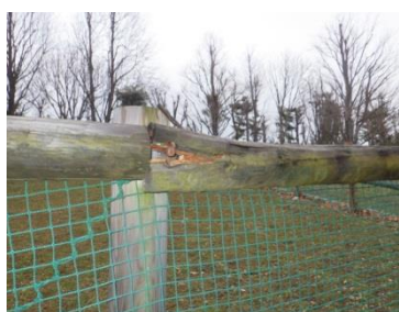
横木破損状態
