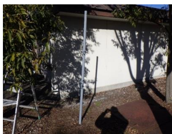
看板撤去、支柱錆取り、錆止め塗装
