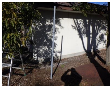
看板撤去、支柱錆取り、錆止め塗装
