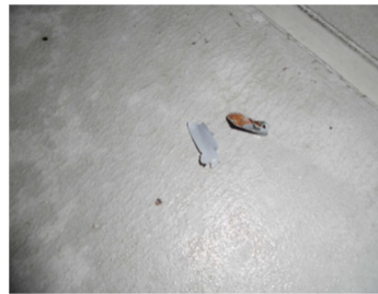
散水栓内部異物除去
