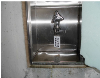
W4 散水栓修繕後
