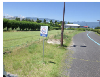
6kmポスト修理完了
