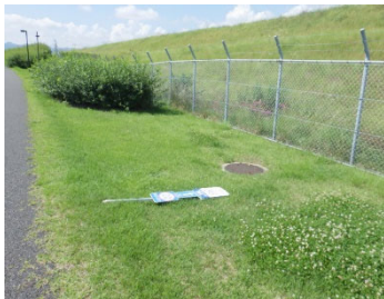
5kmポスト破損状況
