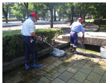
高圧洗浄機洗浄
