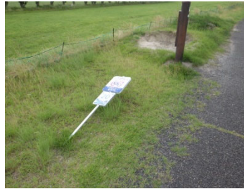
6kmポスト破損状況
