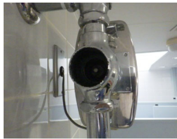
電磁弁押し棒部を点検
