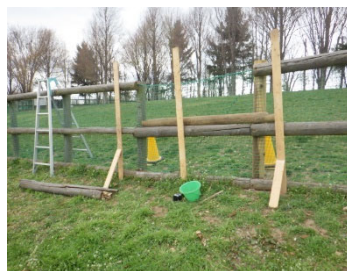
仮補強 横木取外し
