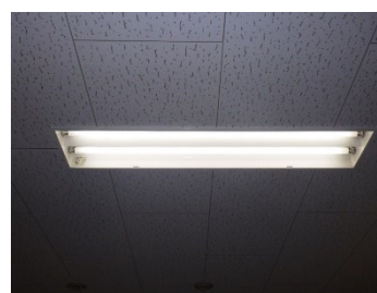
事務所蛍光ランプ取替後
