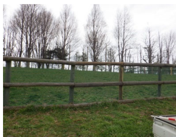
交換完了状況
