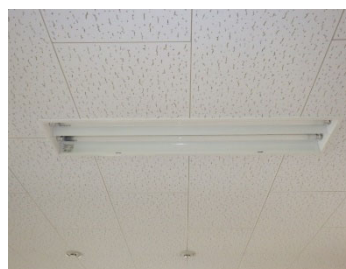
事務所蛍光ランプ取替前
