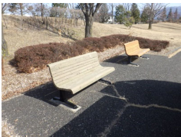
修繕後ベンチ①
