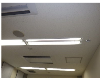
第3会議室 蛍光ランプ取替後
