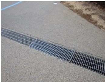
交換完了状況
