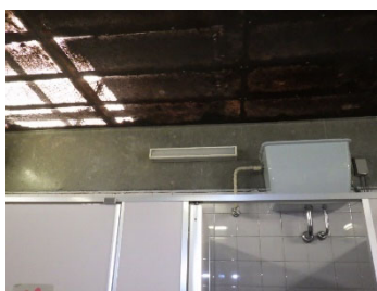
女子トイレ蛍光ランプ 取替前
