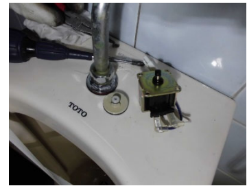
電磁弁及びピストンバルブ部 取り外し状況
