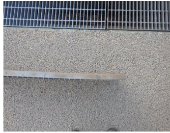
取り外したグレーチング
