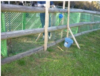
小型犬東側柱交換 仮囲い・横棧支持
