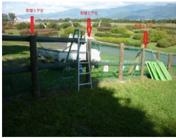
大型犬北側 柱交換 着手前状況
