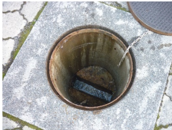
南側 汚水枥②除去作業後
