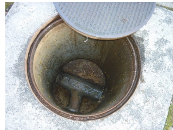
南側 汚水枥① つまり解消 後
