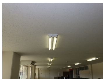
役員室蛍光ランプ取替後
