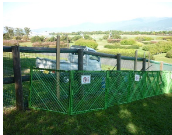
大型犬北側 仮設フェンス設置
