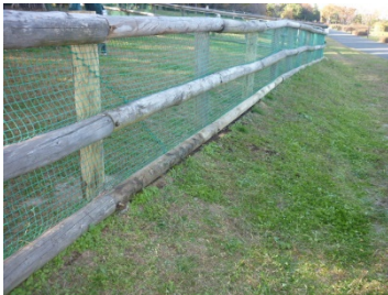
小型犬東側 柱・横棧交換完了
