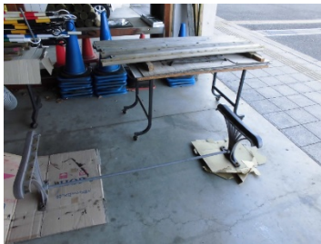
座板取り外し
