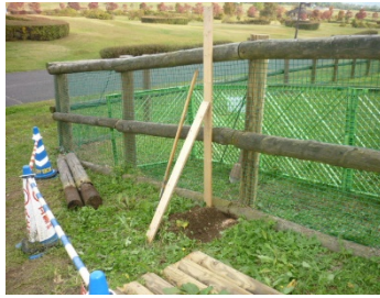
大型犬北側柱引抜き・交換完了状況
