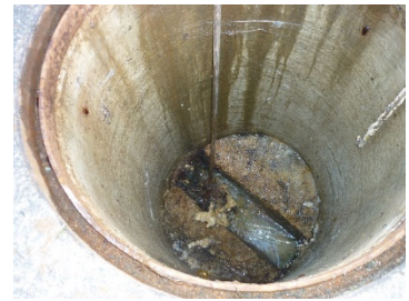
木の根の除去作業
