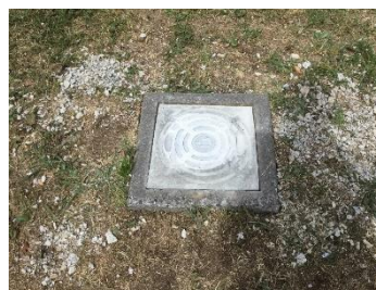
排水桝蓋 交換後
