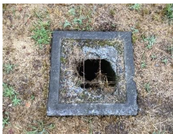
排水桝蓋 交換前
