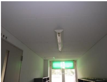
蛍光ランプ取替前
