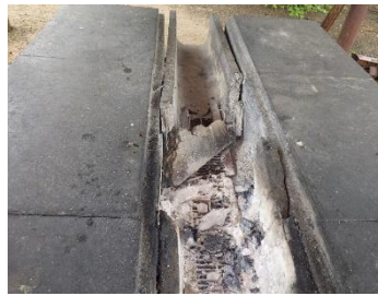
パーベキューピット U 字溝取替前
