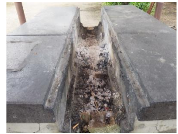
パーベキューピット U 字溝取替状況
