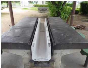
パーベキューピット U 字溝取替後
