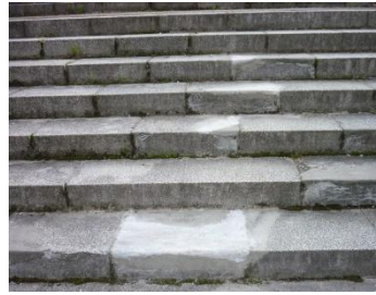
修理完了状況
