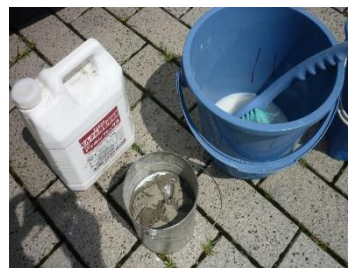
モルタル接着増強剤混合
