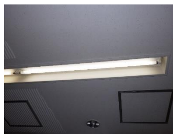
ホール蛍光ランプ取替後
