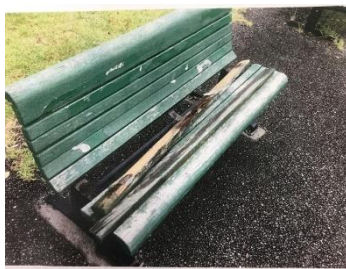
着手前腐朽状況
