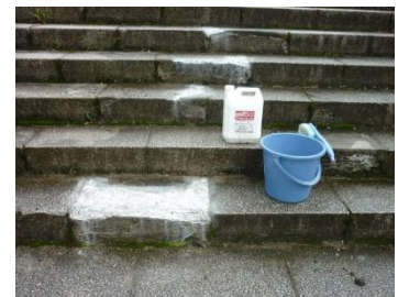
モルタル接着増強剤散布
