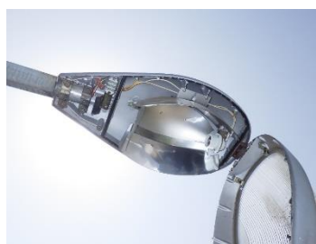
外灯ランプ取替状況
