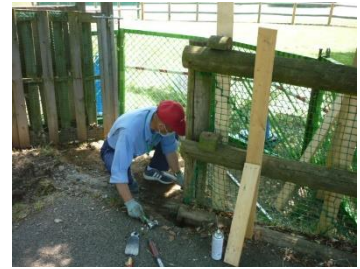
柱取り外し作業
