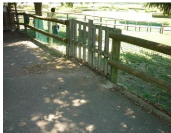
柱交換完了状況
