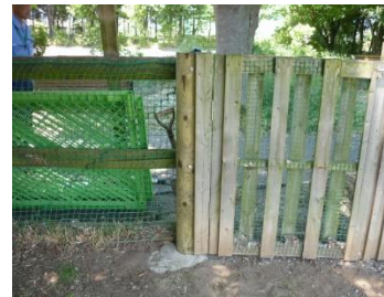
柱取替完了状況
