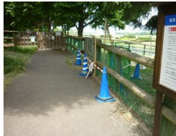
柱交換準備 内部に仮フェンス設置
