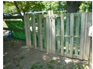
仮フェンス取外完了状況
