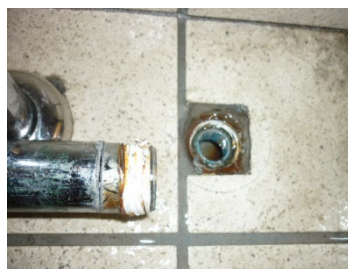
メッキ配管取外し
