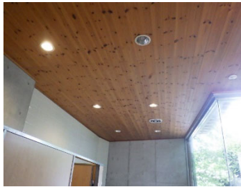
男子トイレ ランプ取替前
