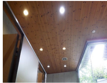
男子トイレ ランプ取替完了
