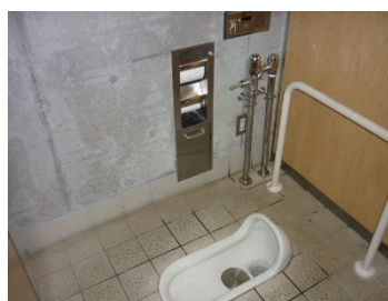
メッキ配管取替完了状況
