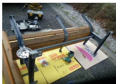
作製した板の取り付け
