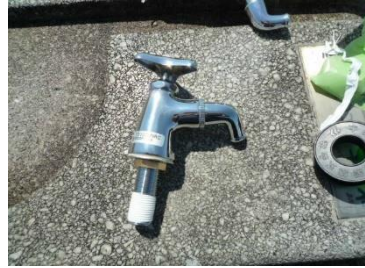
新品蛇口 ビニールテープ巻き付け
