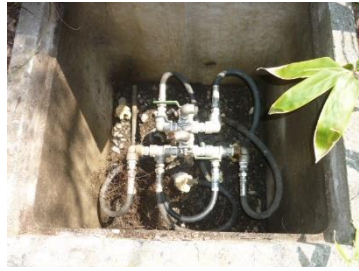
高圧ホース取替え状況
