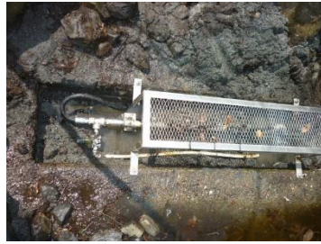
ミストノズル配管接続
