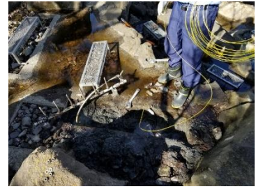
高圧ホース取替 取外し状況
