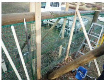
新支柱入れ替え
