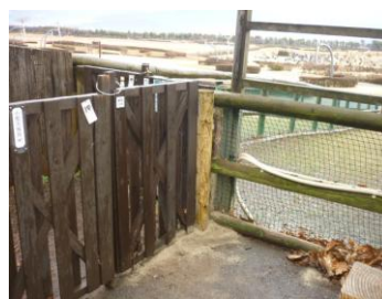
支柱交換作業後
