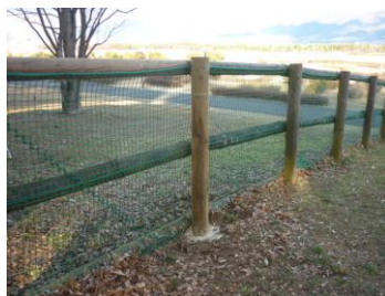
新支柱 横木 交換作業後
