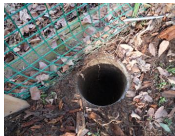
支柱取り外し
