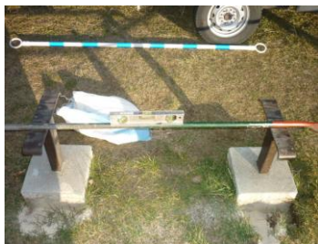
基礎・フレーム水平調整
