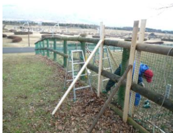
支柱交換用添木取り付け
