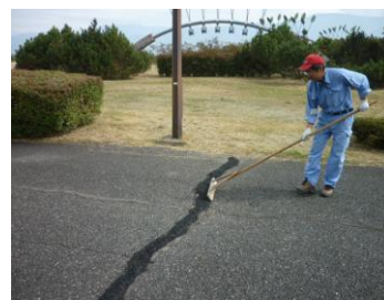
常温合材布設
