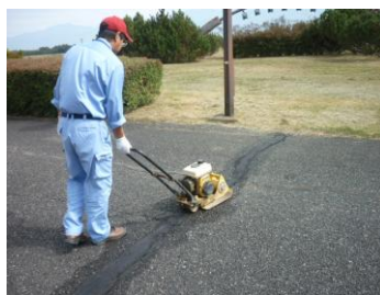
プレート式填圧機使用
