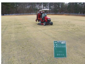
作業状況(多目的球技場)
