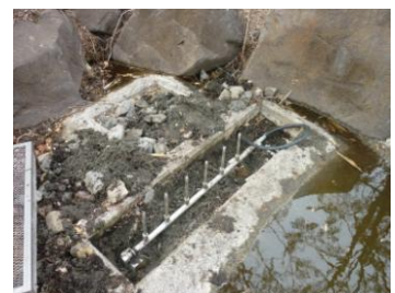
高圧ホース交換完了
