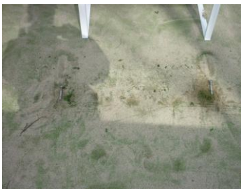
既存固定アンカー取外し
