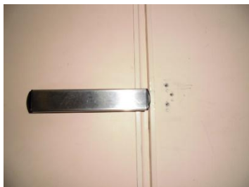
受け部分金具取外し
