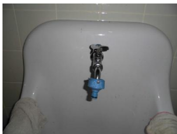
着工前(SK 内水栓)
