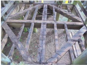
根太材腐朽状況確認
