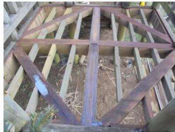
根太材交換取付け完了
