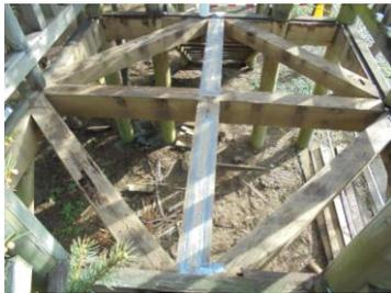
梁材補強・根太材取外し
