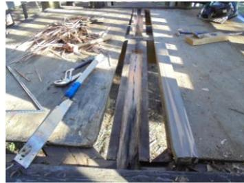
梁材腐朽部分除去
