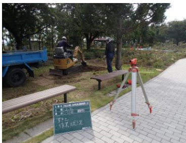
鋤土作業状況
