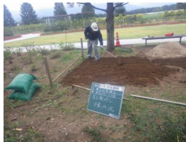
客土敷均し作業状況
