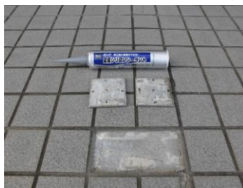
コーキング剤及び塗布箇所
