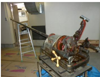
立上げ配管のネジを切り直し
