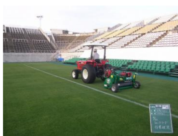
作業状況(総合球技場)
