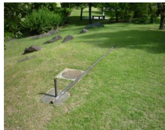
強度確認で揺らしたら 配管がたおれた
