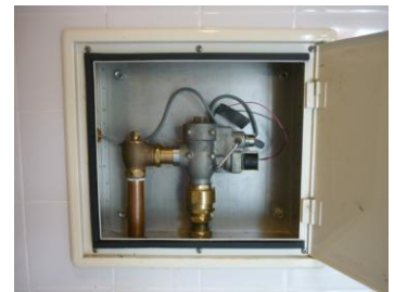
完了・動作確認
