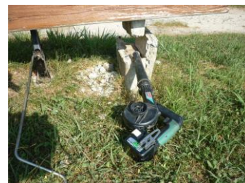
基礎破損部清掃
