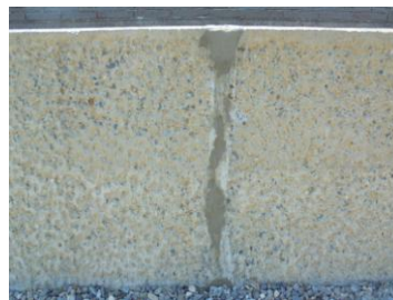
モルタル補修
