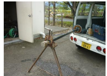
フート弁取外し
