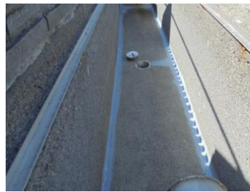
防水塗装完了
