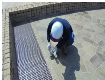
モルタル注入
