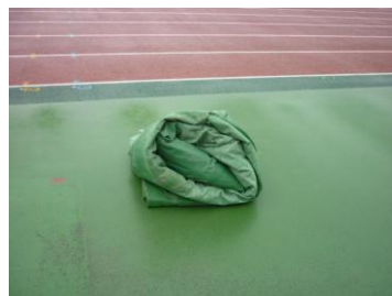
既存カバー撤去状況
