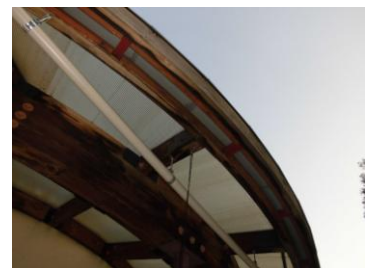
工事箇所塗装
