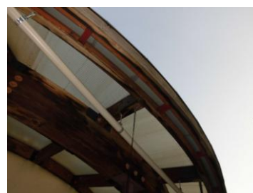
工事箇所塗装
