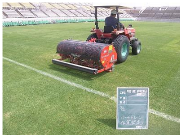
作業状況(総合球技場)
