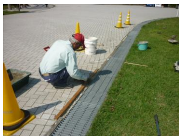
グレーチング取付け 枠部打設
