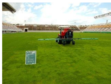
作業状況(総合球技場)
