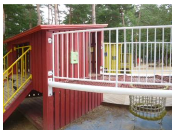
一時養生状況
