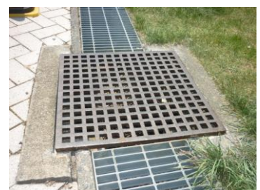
格子柵蓋 調整完了
