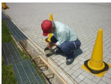
モルタル打設
