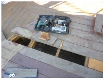
破損箇所取外し
