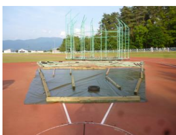
グリーンシート取付け
