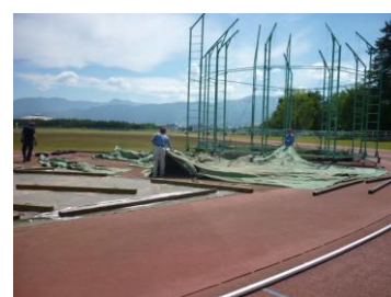
奥側シート取外し
