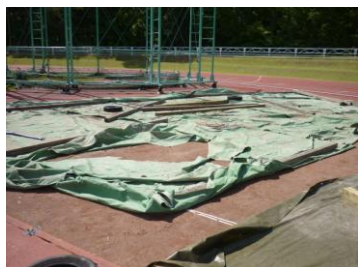
着手前 奥側カバーシート
