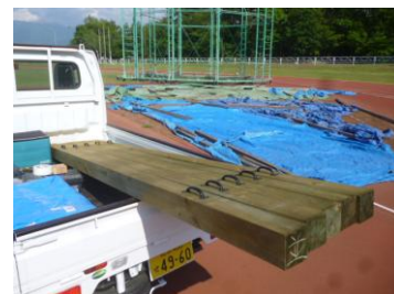
シート押さえ角材搬入
