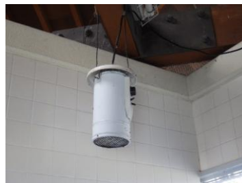
天井ヒーター撤去前
