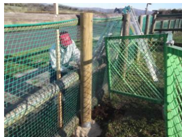
更新用支柱取付 2
