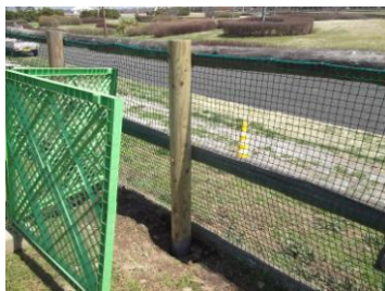
更新用支柱取付 1
