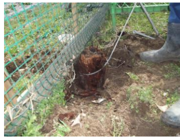
既設支柱撤去
