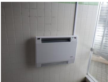
パネルヒーター取付後
