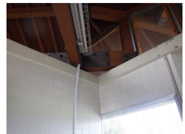
天井ヒーター撤去後
