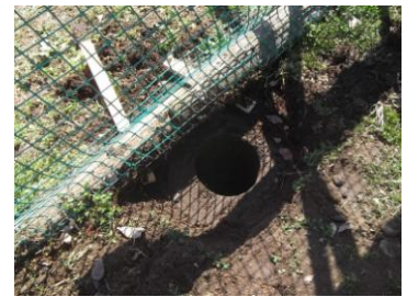
既設支柱撤去完了
