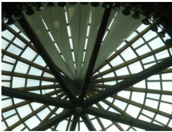
遮光カーテン取付け状況
