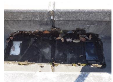
階段ステップ取り外し状況
