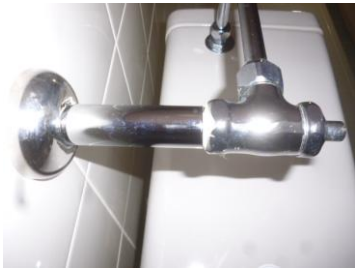
メッキ管取替え完了
