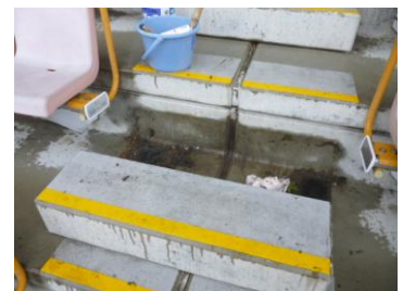
メインスタンドのシーリング状況
