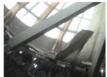
取外し状況拡大
