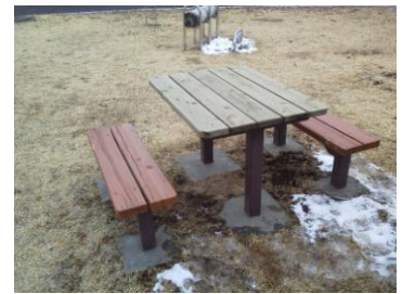
テーブル板交換完了
