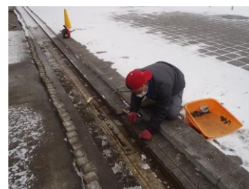
幅止めピン設置状況
