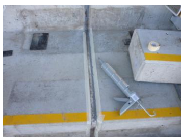
ひび割れ部シーリング充填
