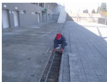
平板ブロック撤去状況
