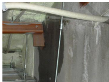
天井内の状況
