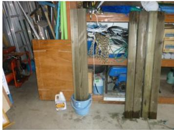
柱加工 切断部 ACQ 剤処理
