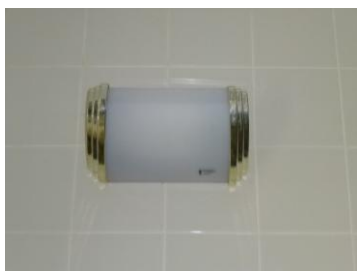
男子トイレ洗面台 ツイン蛍光灯取替前
