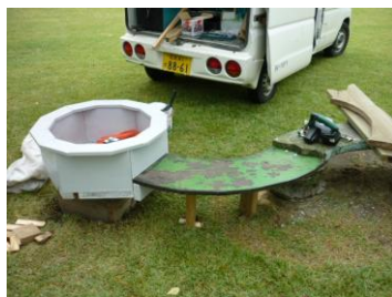
花壇部・下地合板取付け
