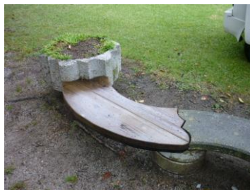
座板取付け完了
