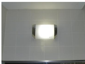
男子トイレ洗面台 ツイン蛍光灯取替後
