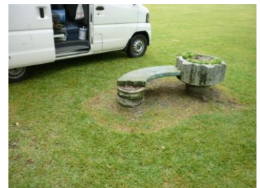
花壇部損壊箇所
