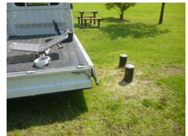
上部取外し状況
