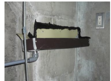
受樋周囲コーキング剤塗布 排水管接続
