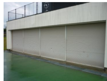
シャッター三ヶ所修理完了
