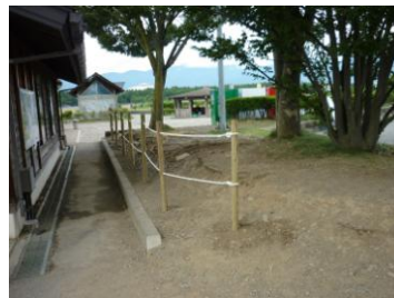
木柵設置完了
