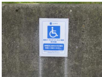
第1駐車場 パーキング・パーミット案内表示取付後 1
