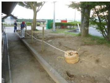
ロープ取付け
